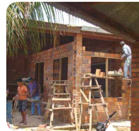
De verbouwing is in volle gang. Dank aan iedereen die 'een steentje heeft bijgedragen'!
